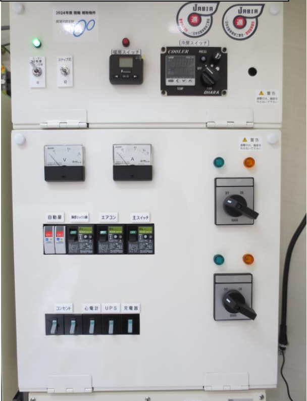
冷房操作部・暖房操作部・電源切替配電盤
